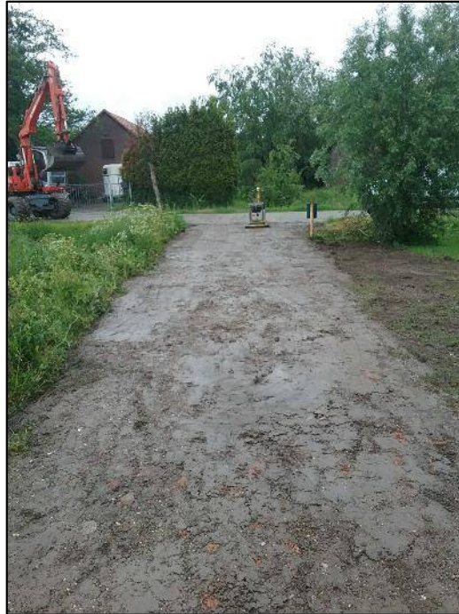
Aanvullen en afwerken van de oprit
