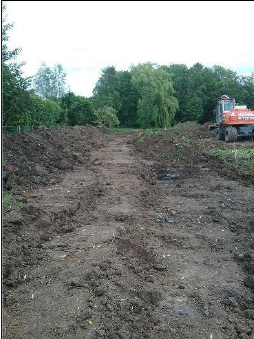
Ontgraven van de oprit
