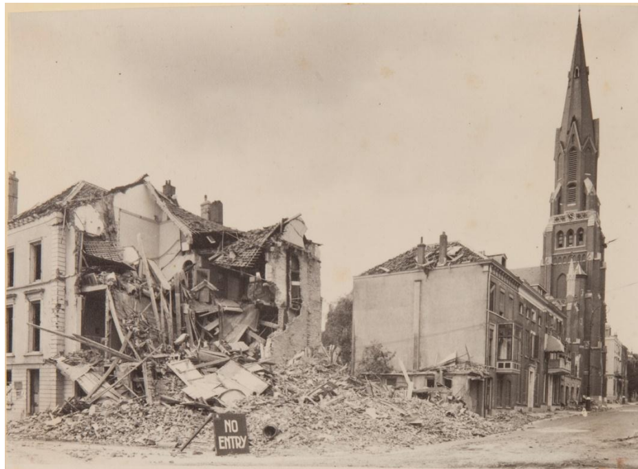
Figuur 2.7 Oorlogsschade hoek Oude Kraan-Nieuwe Plein. Rechts de R.K. Sint Eusebiuskerk of Kleine Eusebius (Gelders Archief, fotograaf: D. Renes).
