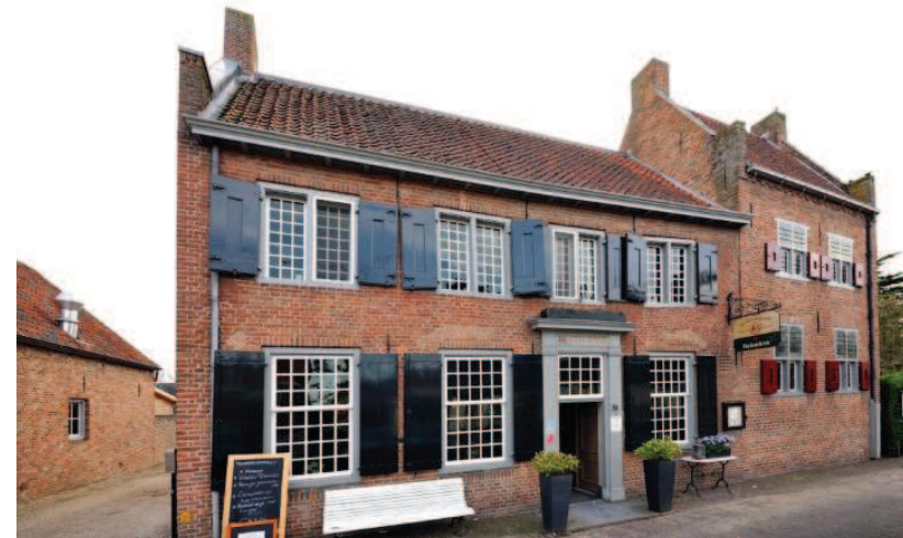
Bebouwing direct aan het plein
