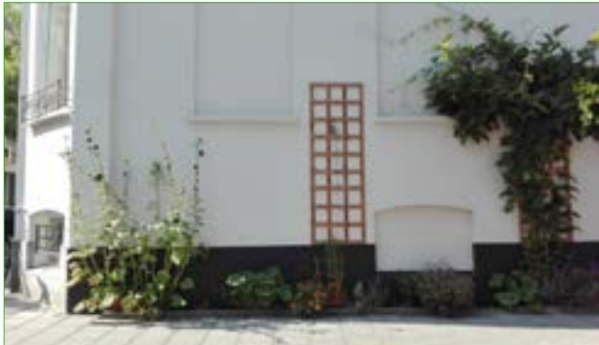
Een groen dak in Arnhem Groen West AAN / Een net aangelegde geveltuin in het Spijkerkwartier © Marleen Michels
