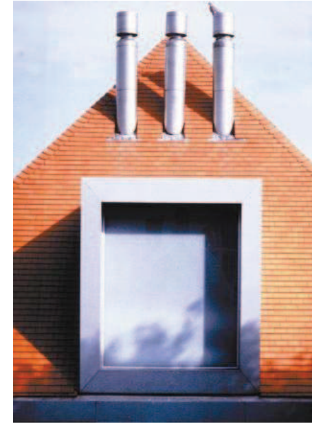
uitgesproken dakuitbouw aan kroonlijst
