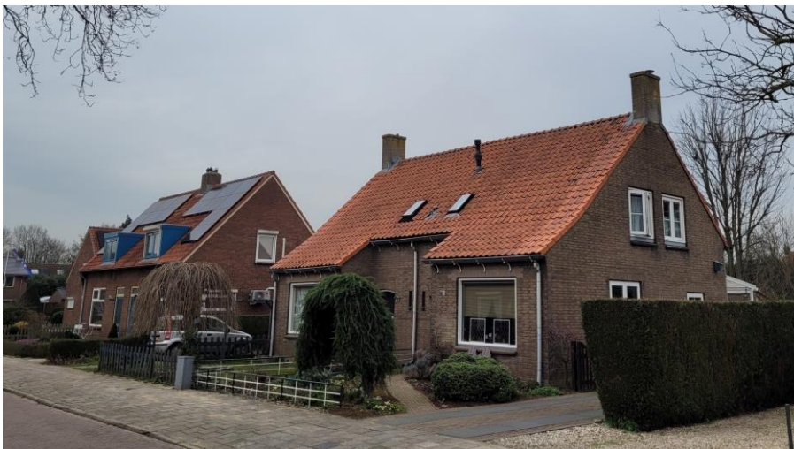
Vroege wederopbouwwoningen aan de Oosterveldsestraat
