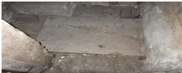
Foto 24 | Foto voor bron vlakke plaat (losse kruipluik) (nieuw)
