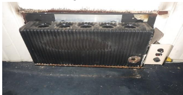
Foto 37 | Foto voor bron koord en/of pakking in gevelkachel (nieuw)
