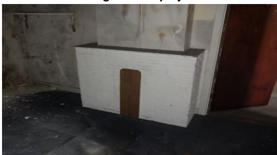
afbeelding 48: Foto project schouw
