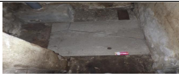
Foto 19 | Foto voor bron vlakke plaat (losse kruipluik)
