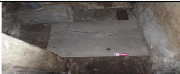
Foto 18 | Foto voor bron vlakke plaat (losse kruipluik)
