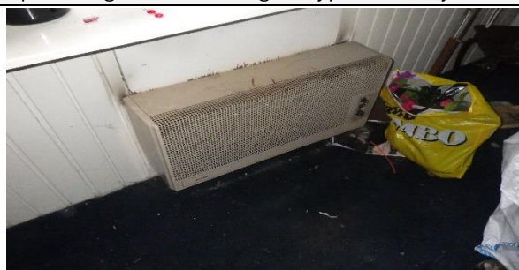
Foto 28 | Foto voor bron koord en/of pakking in gevelkachel
