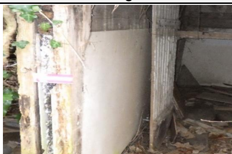
Foto 21 | Foto voor bron vlakke plaat (sandwichpanelen)
